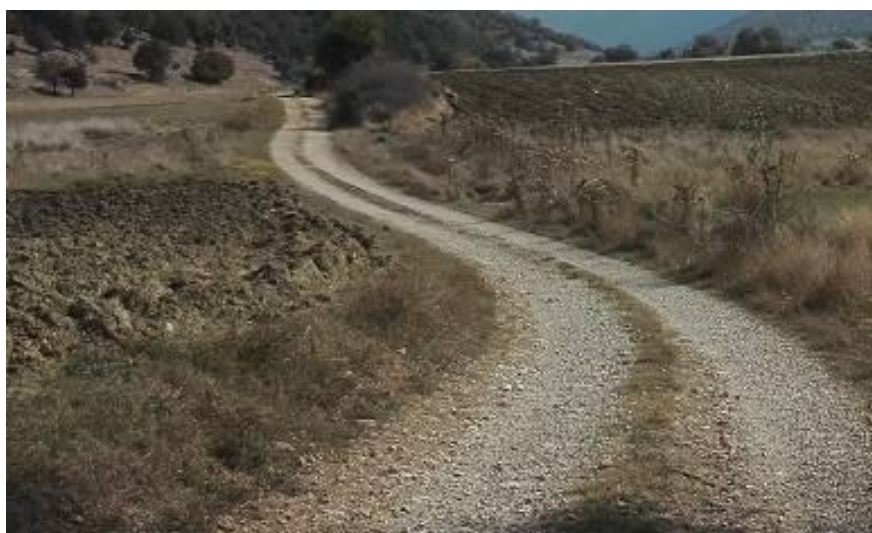
Φωτ. 5.2: Άποψη της προς βελτίωση Οδού 2
