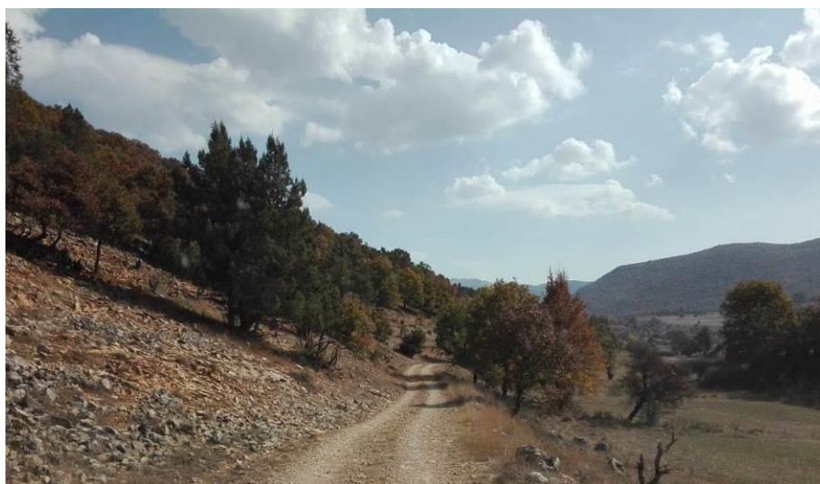
Φωτ. 5.3: Άποψη της προς βελτίωση Οδού 3.
