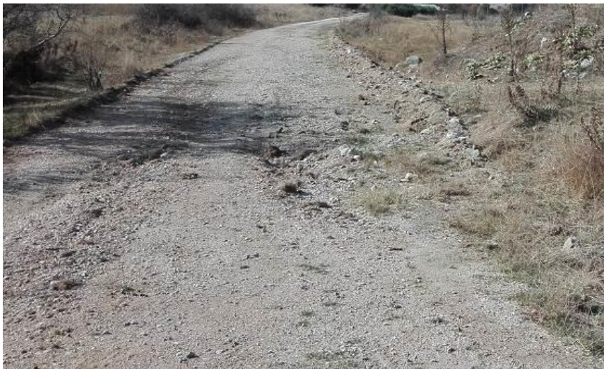
Φωτ. 5.1: Άποψη της προς βελτίωση Οδού 1.
