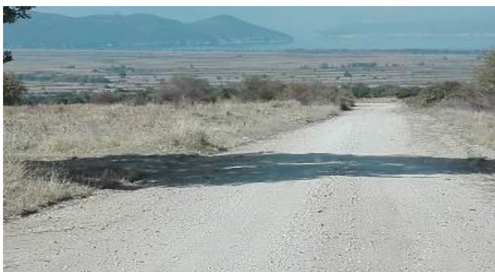
Φωτ. 5.6: Άποψη της προς βελτίωση Οδού 6.
