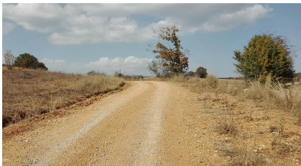
Φωτ. 5.5: Άποψη της προς βελτίωση Οδού 5.
