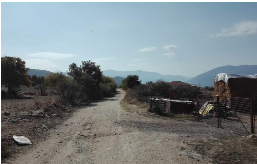
Φωτ. 5.7: Άποψη της προς βελτίωση Οδού 7.
