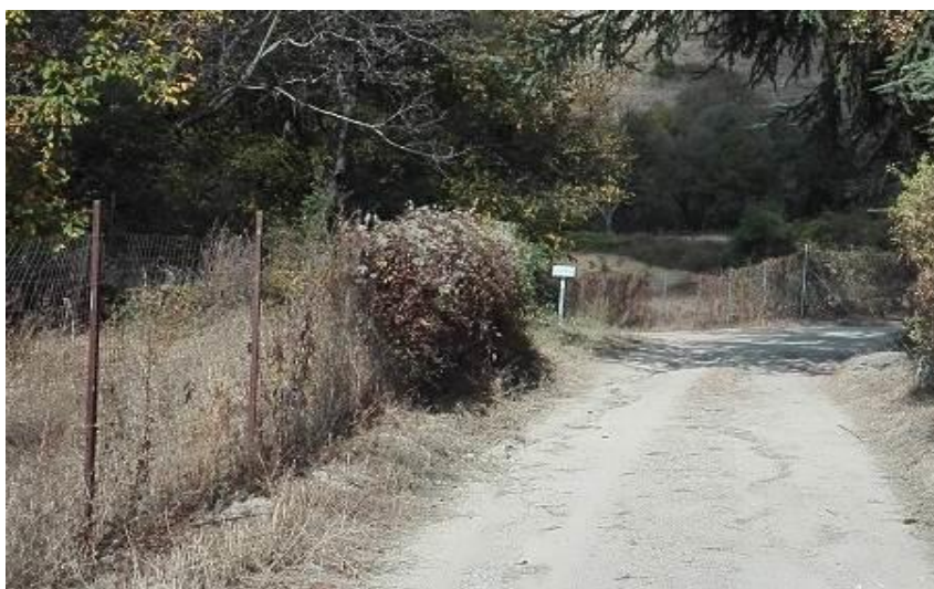
Φωτ. 5.8: Άποψη της προς βελτίωση Οδού 8.
