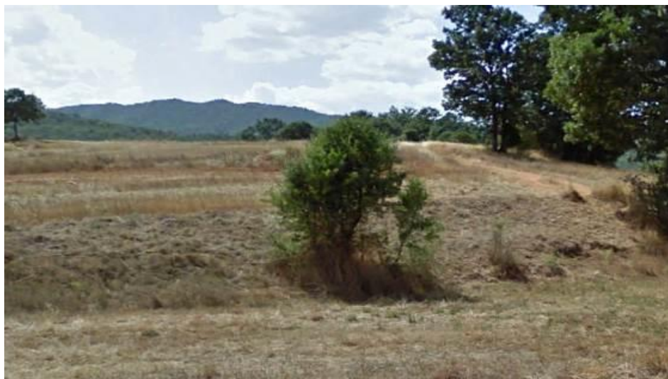
Φωτ. 5.4: Άποψη της προς βελτίωση Οδού 4.
